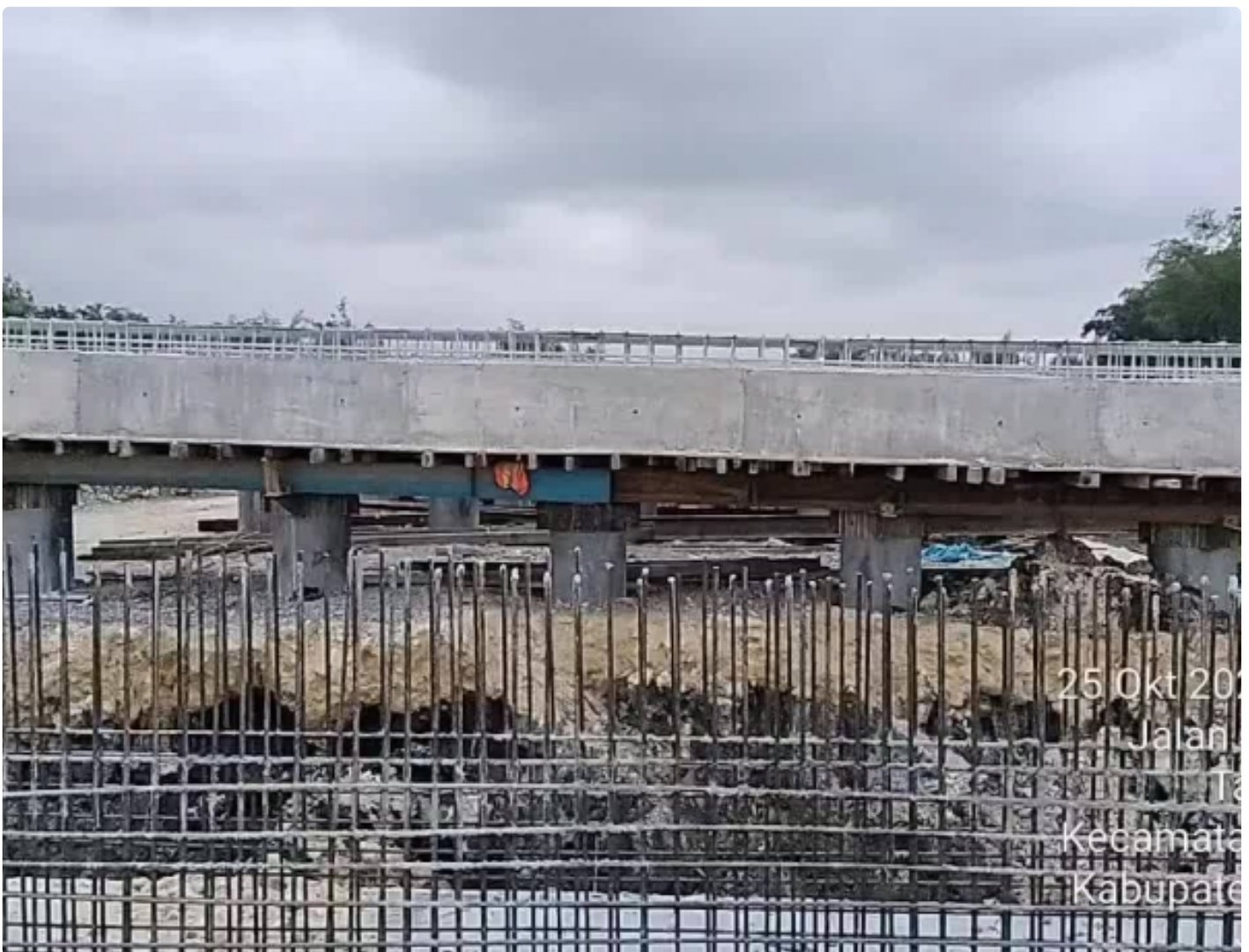
Lokasi Pembangunan JLS Sampang yang masih dikerjakan
